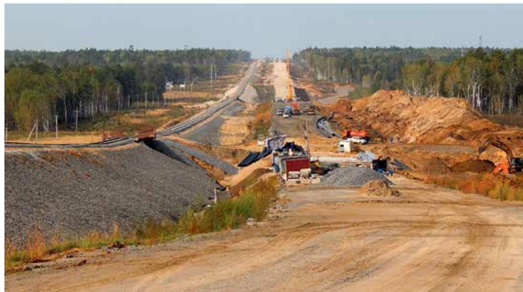
↑↑ Строительство железной и автомобильной дороги — центрального проспекта космодрома Восточный.
