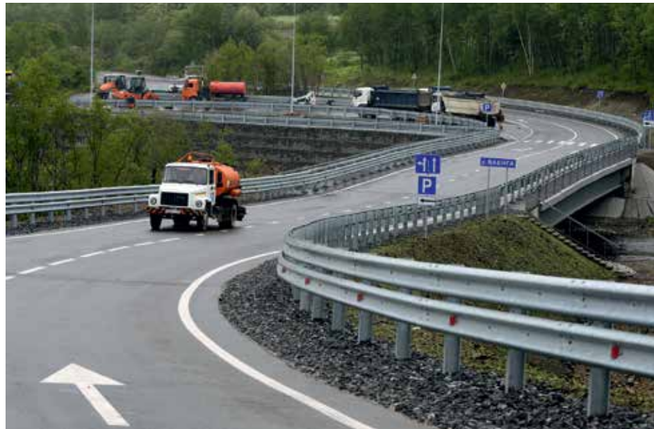
↑↑ Мост через реку Ваенга
