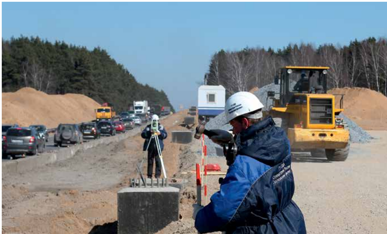
↑↑ Главное управление строительства дорог и аэродромов ведет реконструкцию участков Старосимферопольского шоссе
