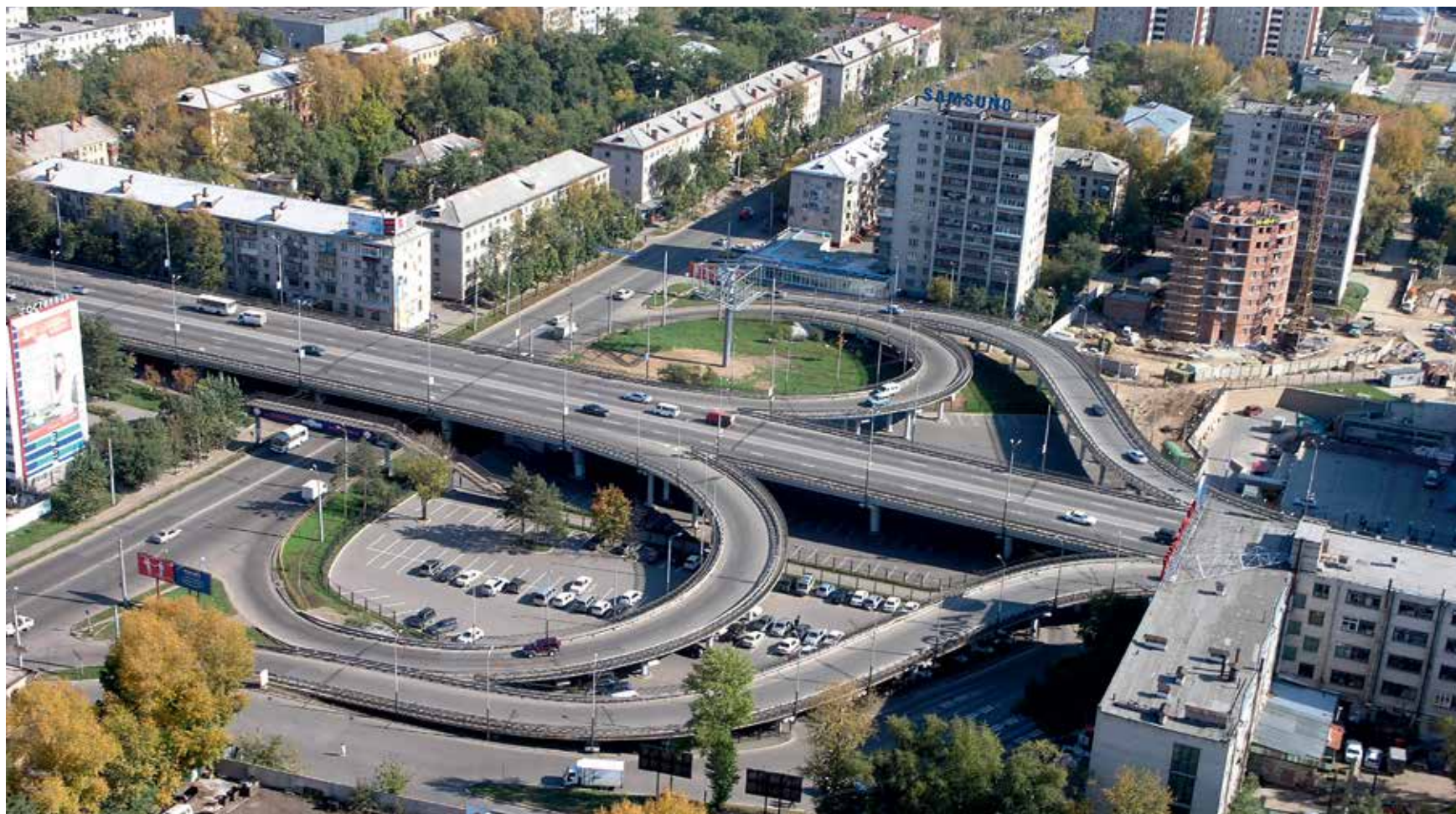
↑↑ Дорожная развязка по ул. Муравьева-Амурского — Ленинградская в Хабаровске.
