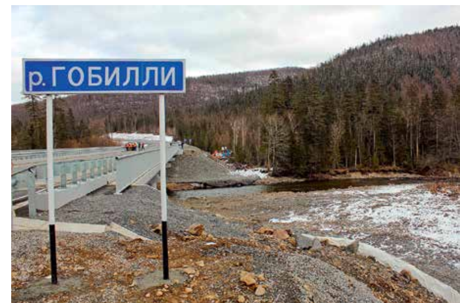
†† Мост через реку Гобилли на 164 км трассы Хабаровск — Лидога — Ванино
