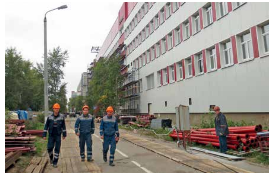
†† На строительной площадке цеха по ремонту и модернизации атомных субмарин
