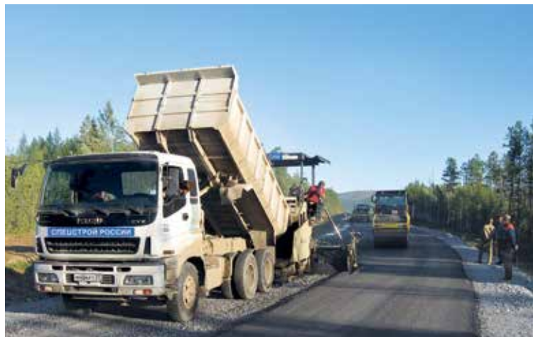
↑↑ Устройство верхнего слоя основания из пористой асфальтобетонной смеси участка автомобильной дороги Селихино — Николаевск-на-Амуре, км 412 — км 430.
