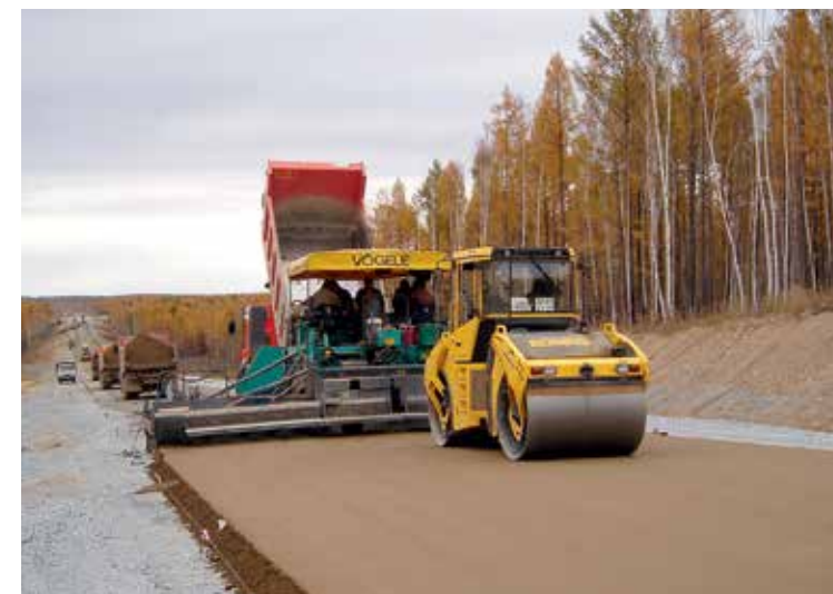
↓↓ Устройство слоя полимерцементогрунтовой смеси участка федеральной автомобильной дороги «Амур» км 1109 — км 1127.
