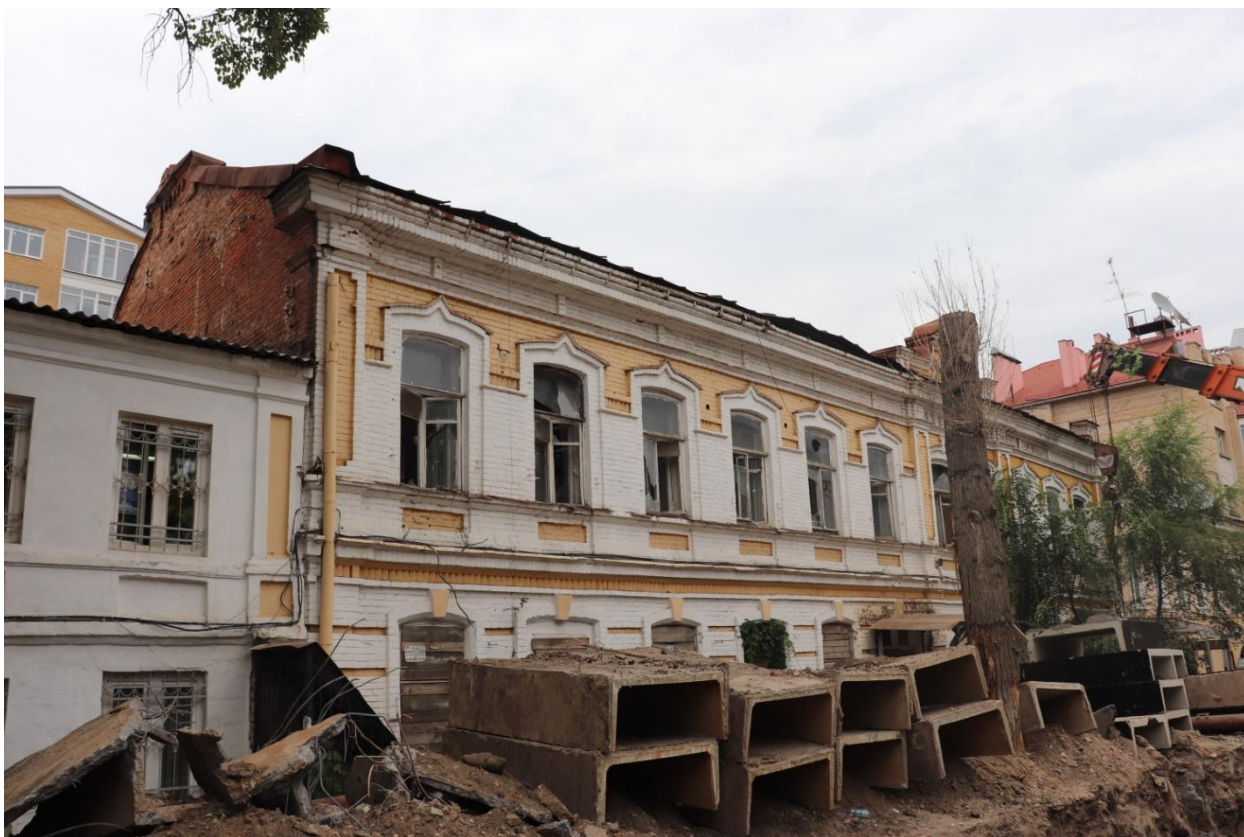
Фото 2. Главный фасад исследуемого объекта, вид с юго-запада. Дата фотофиксации 10.08.2021 г.
