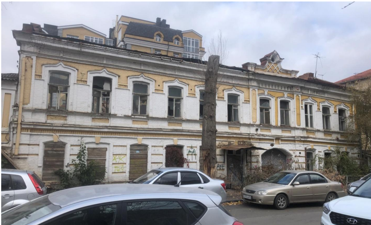
Фото 1. Главный фасад исследуемого объекта, вид с юга. Дата фотофиксации 25.10.2021 г.
