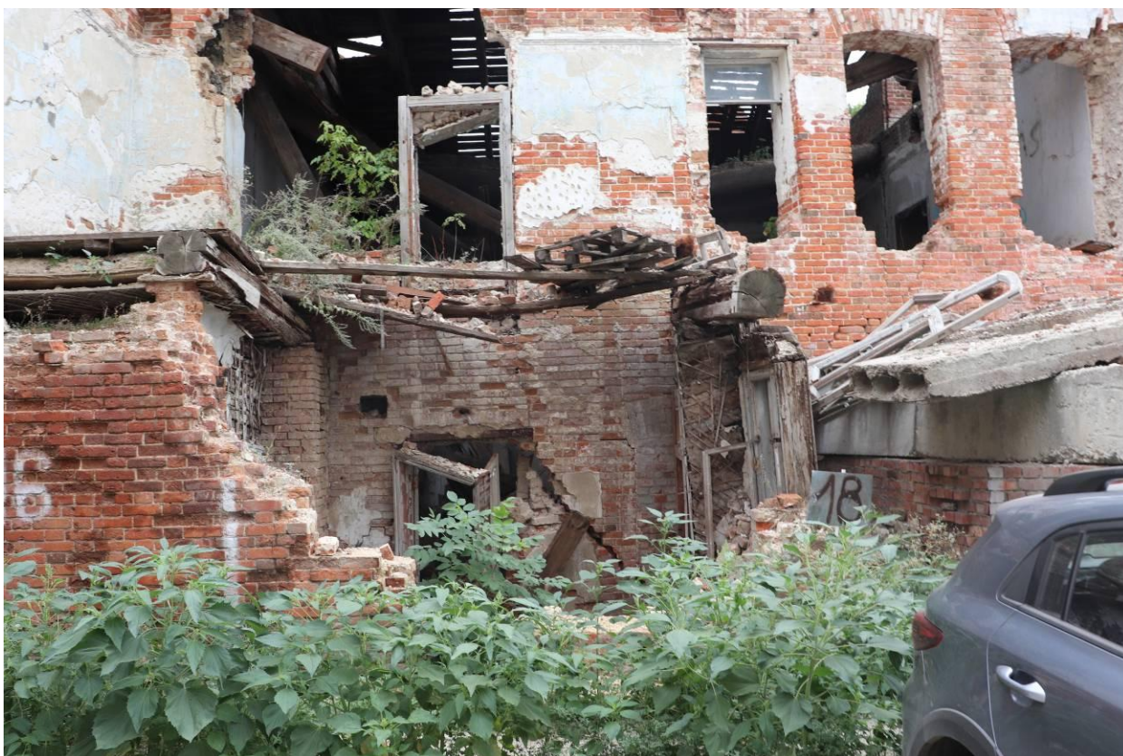
Фото 9, 10. Фрагменты дворового фасада. Дата фотофиксации 10.08.2021 г.
