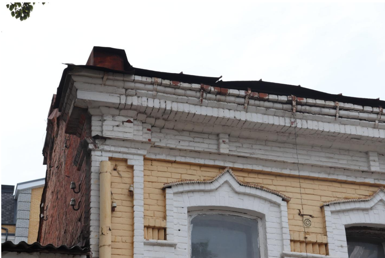
Фото 5. Фрагмент главного фасада. Профилированный венчающий карниз. Дата фотофиксации 10.08.2021 г.
