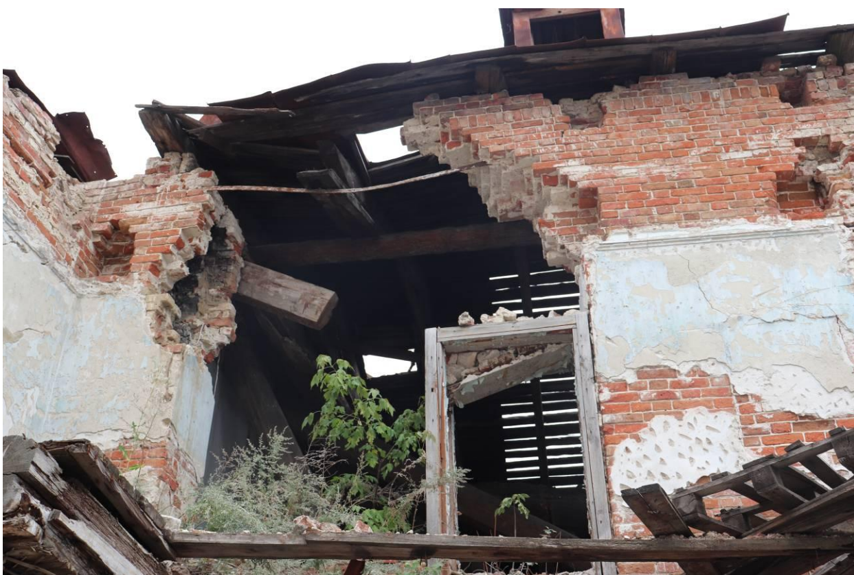
Фото 11, 12. Фрагменты дворового фасада. Дата фотофиксации 10.08.2021 г.
