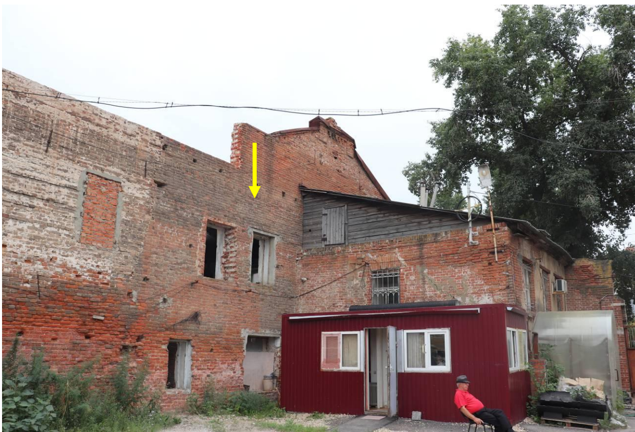
Фото 7. Торцевой (западный) фасад (обозначен стрелкой). Справа – соседнее здание (№126 по ул. им. Челюскинцев). Дата фотофиксации 10.08.2021 г.
