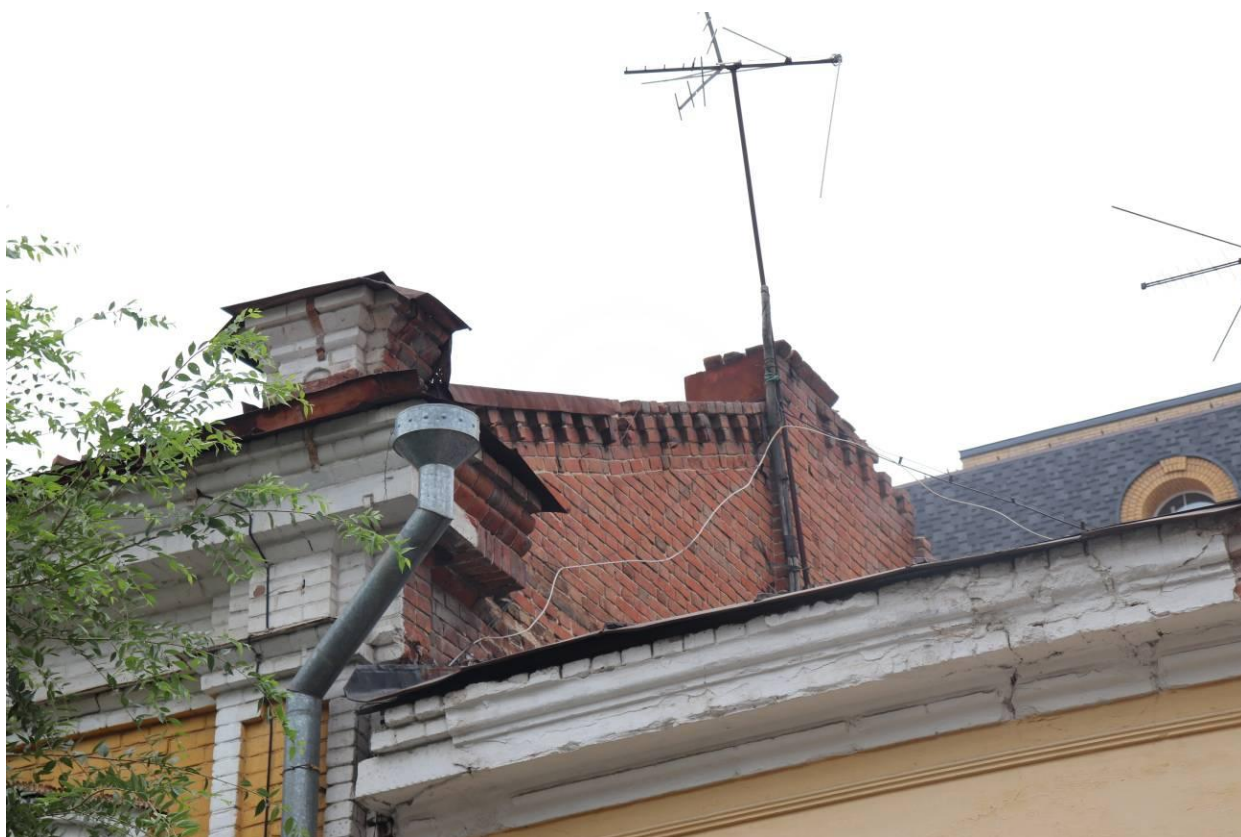
Фото 6. Фрагмент торцевого (восточного) фасада. Дата фотофиксации 10.08.2021 г.
