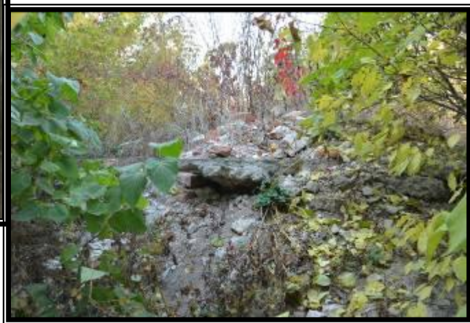
Фото 5. Фундамент главного дома. Фото автора
