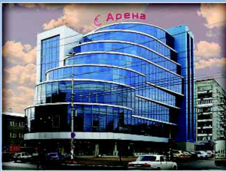
Архитектор В.А.Архангельский. Торгово-административный центр на углу улиц Чапаева и Б.Казачьей. 2006-2008 гг. (строительство)
