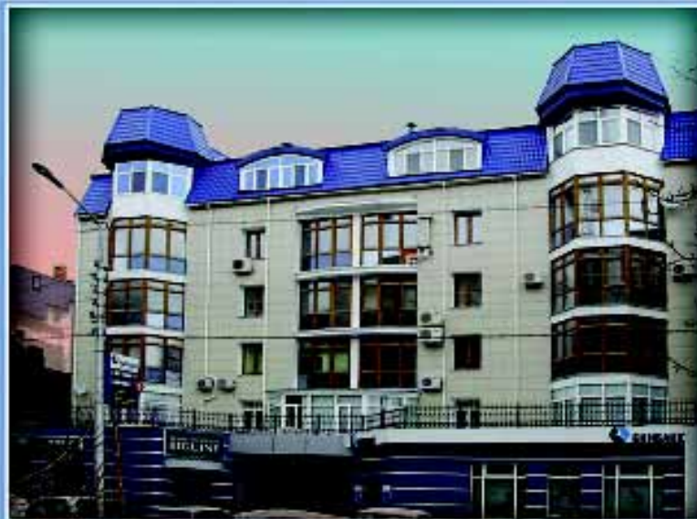
Архитектор Д. В. Голубинов. Жилой дом на ул. Шевченко, 18. 2005 г. (строительство).
