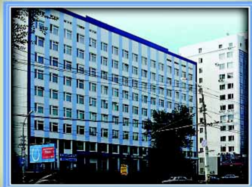
Архитектор К.М.Макулов. Административное здание ОАО «Фрегат». Ул.Чернышевского, 60-62. 1986 г. (строительство)
