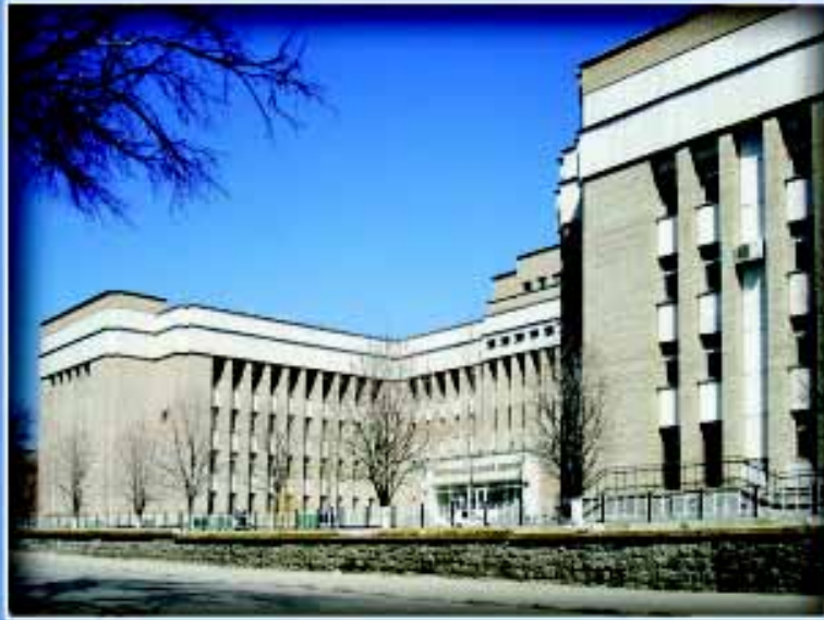
Архитекторы Д.В. Ганке, Д.В. Голубинов, В.Г. Пахомов. Родильный дом углу улиц Рабочей и Аткарской. 1990-1995 гг. (строительство)
